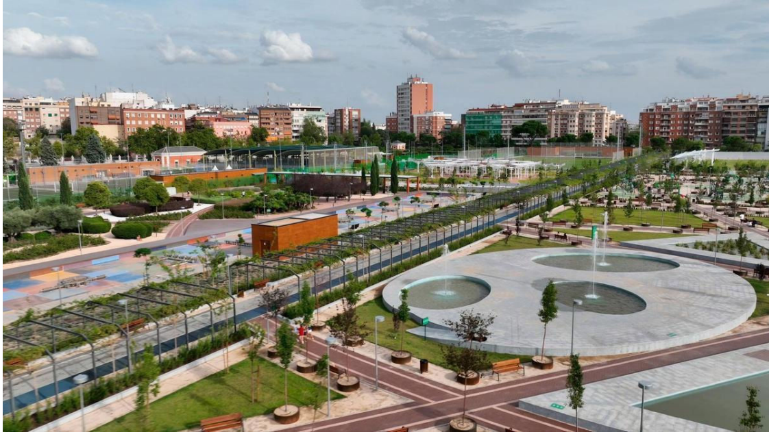
Instalaciones de Canal de Isabel II / COMUNIDAD DE MADRID
